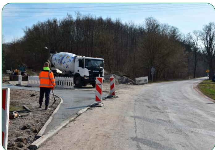
Przebudowa drogi w Brukach Unisławskich (pod górami) na odcinku 600 m. Wartość zadania to 1,2 mln zł.
