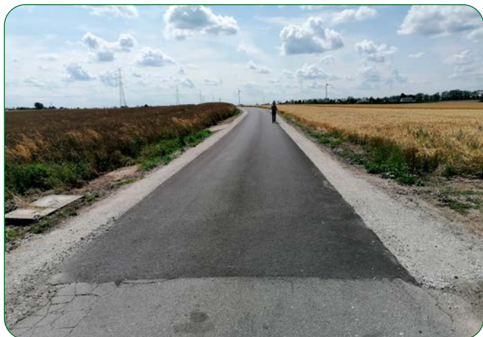
Przebudowa drogi w Grzybnie, całość inwestycji wyniosła 615 tys. zł.
