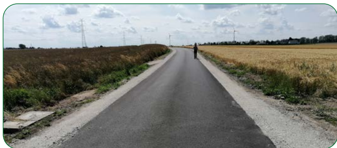
Zmodernizowana droga w Grzybnie.
