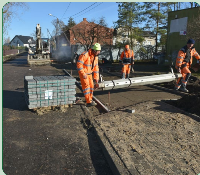
W tym roku zapowiada się wielkie drogowe budowanie za ponad 9 mln zł.
